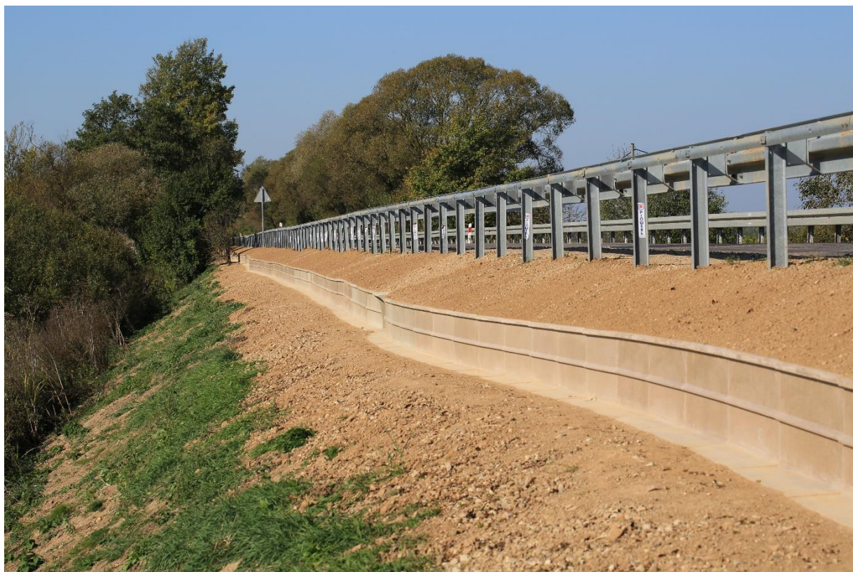
Ryc. 7. Bariery herpetologiczne firmy ACO wykonane z polimerbetonu
