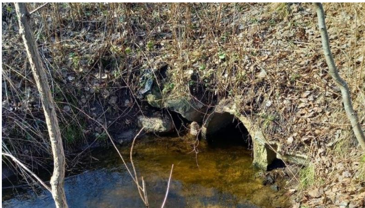
Ryc. 4. Aktualnie istniejący przepust pod drogą gruntową w miejscowości Wyspowo, przez który przepływa rzeka Cedron
