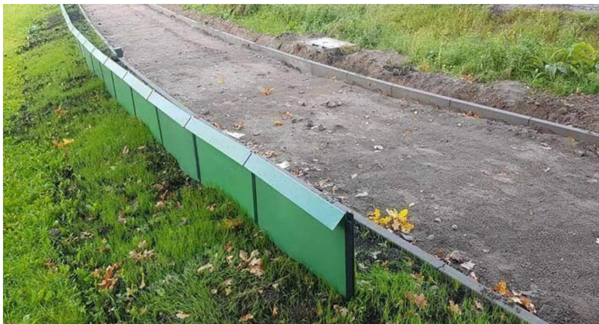
Ryc. 5. Bariery herpetologiczne firmy SIATMAR wykonane z tworzywa sztucznego
