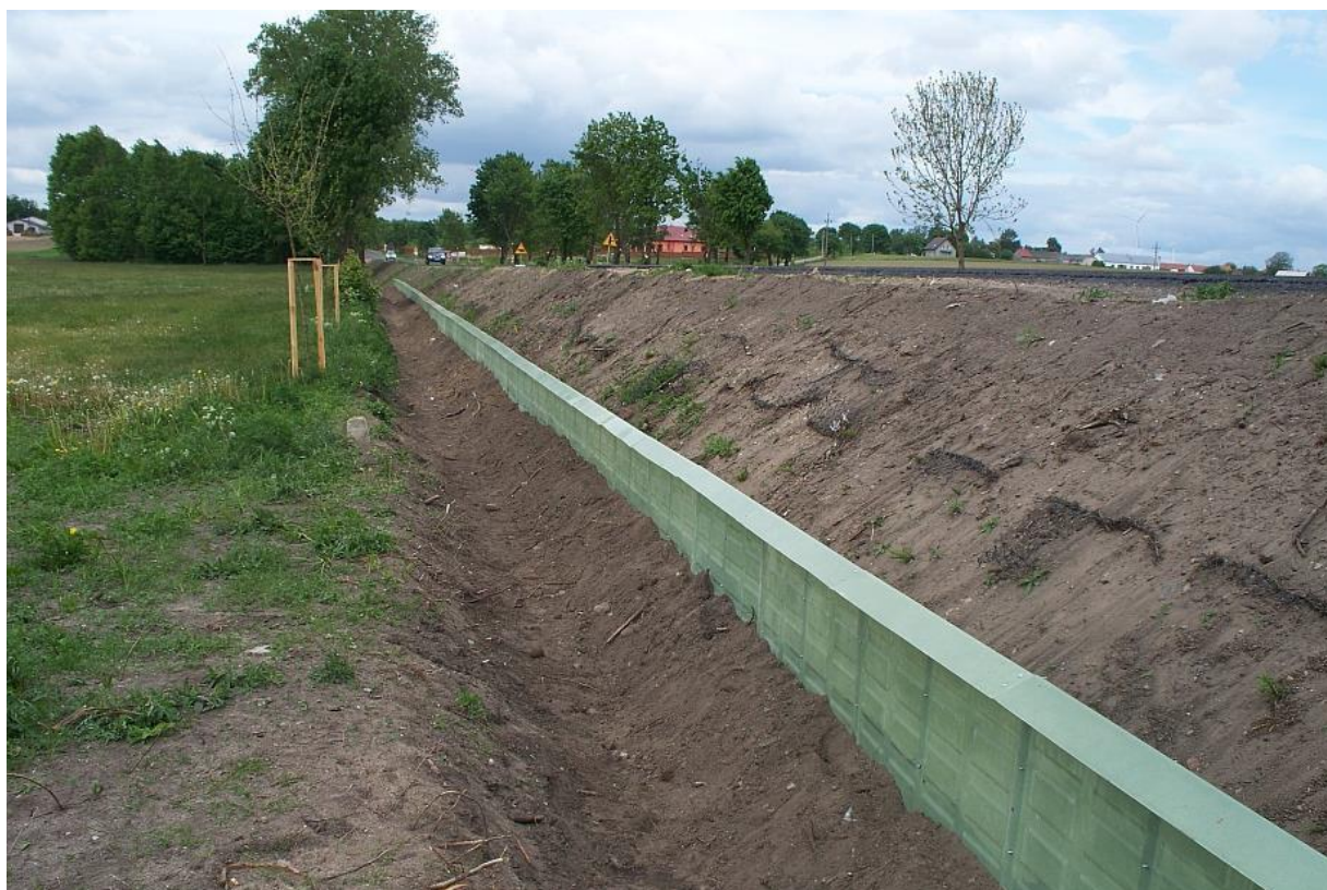
Ryc. 6. Bariery herpetologiczne firmy Pusz wykonane z laminatu poliestrowo-szklanego
