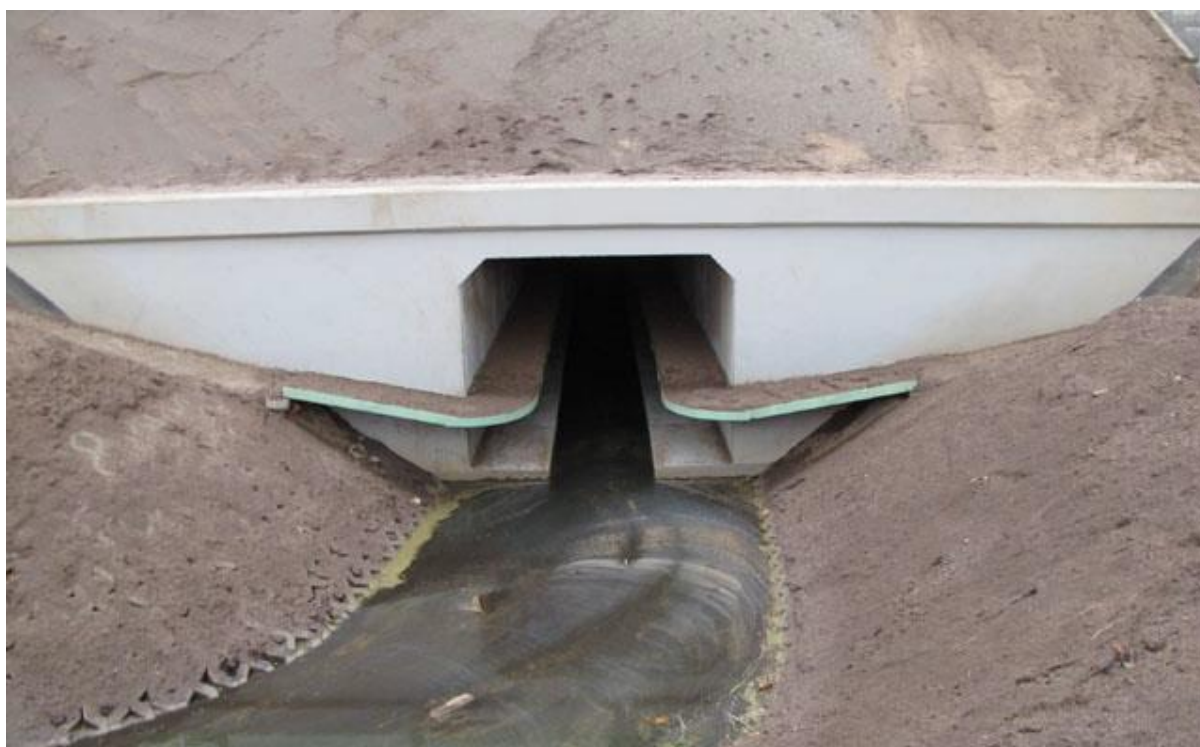
Ryc. 8. Półki suche firmy Pusz wykonane z laminatu poliestrowo-szklanego, zamontowane po obu stronach przepustu
